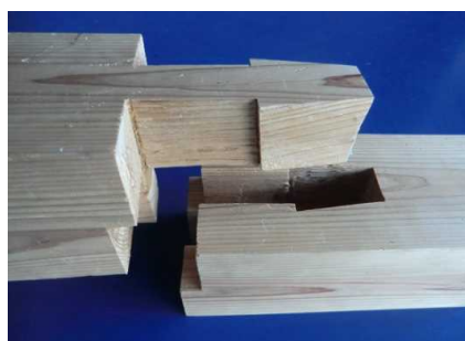
木造軸組材の継手
