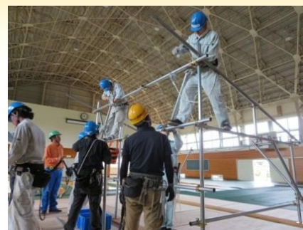
■ とび作業 単管を組み合わせた片屋根小屋の組立て作業
