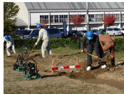
■ 土木基礎作業② 丁張りに合わせた溝掘り作業
