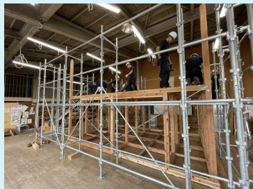
木造住宅施工(家づくり)実習
