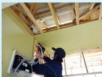
石膏ボード張付作業
