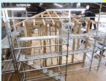
木造住宅施工実習
