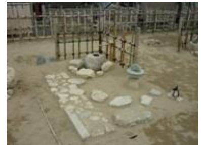
坪庭施工実習
