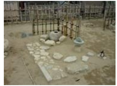
坪庭施工実習
