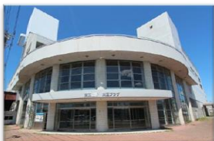
東区プラザ外観
