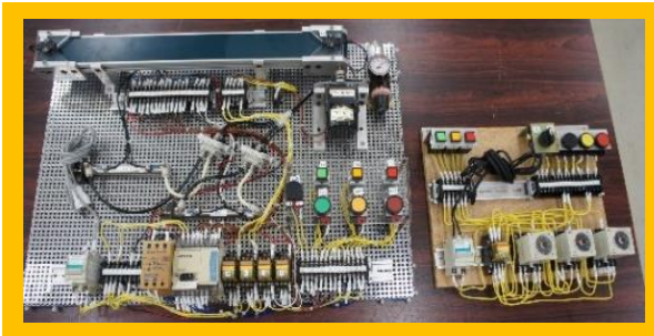
実習機器によるリレー配線・PLCプログラミングの 実技講習を行います
